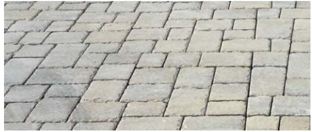
Möglichkeit einer barrierefreien Pflasterung
