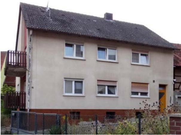
Liegende Fensterformate durch 2 Flügel gleichmäßig unterteilt
