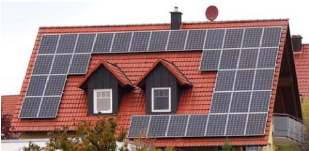
Photovoltaik-Modul. Die Dachränder sollten auf mind. 0,60 m frei bleiben, damit das Dach als Bauteil noch erkannt wird.
