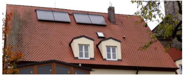
Photothermie- / Solarthermiezellen zur Warmwasseraufbereitung
