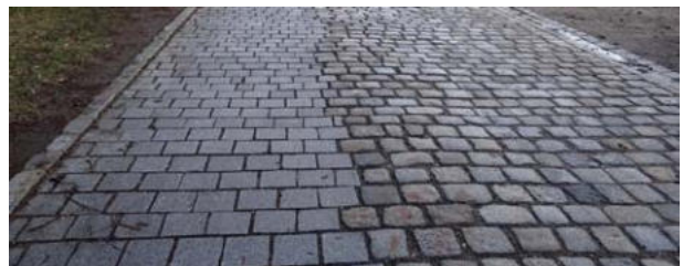
Auch Kombinationen mit traditionellen Natursteinbelägen und eingefügten, barrierefreien Gehstreifen bringen gute Lösungen.
