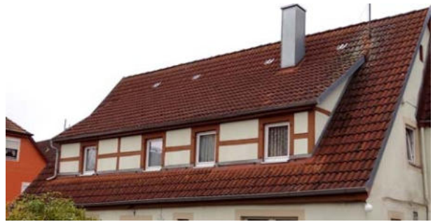
Langgestreckte Gaube mit stehenden Fenstern und abgeschlepptem Dach
